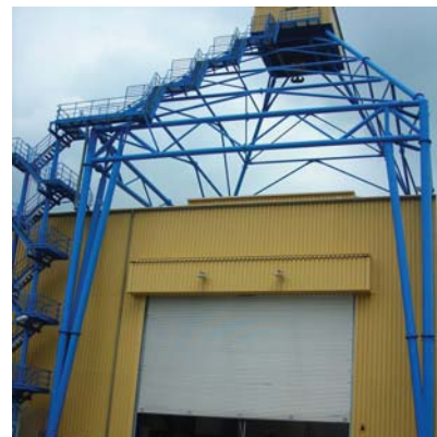
Düşürme Testleri için kullanılan düzenek – bu tesiste resimde gördüğünüz nükleer yakıt tankı 9 m yükseklikten düşürülmüştür.
